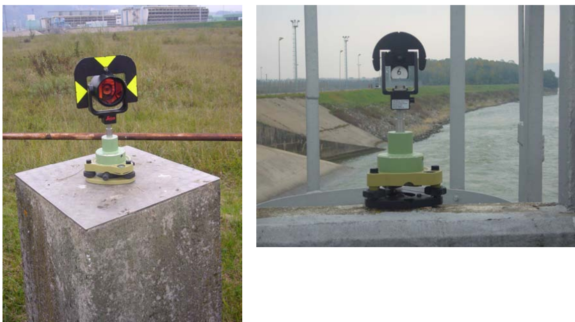
Slika 3 - Stabilizacija in signalizacija opazovalnega stebra in kontrolne točke
