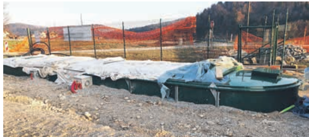
Čistilna v Podolnici že poskusno obratuje, naslednji korak je urejanje okolice in zaščitne ograje.
