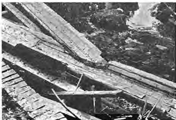
Detajl lobniške riže v Hlebovem peklišu z dotočnim žlebom (foto: M. Mehora)
