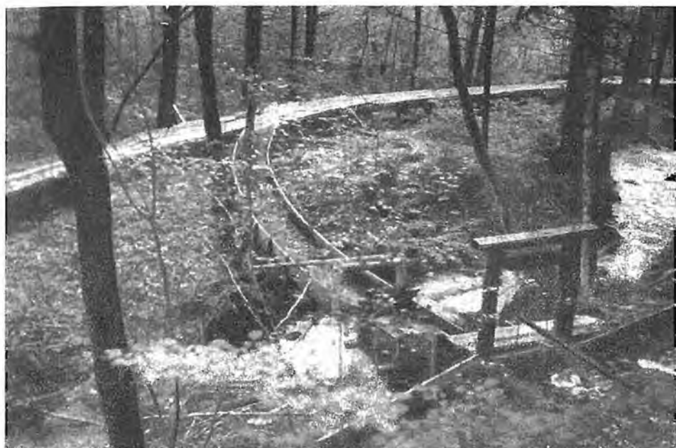
Del lobniške riže nad Hlebovo žago z dotočnim žlebom in zatvornico (foto: M. Mehora)
