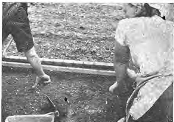
Slika 7: Tretja faza presajanja s priklopko: zasipavanje jarka in poravnanje prsti
