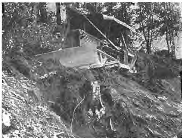
Angledozer izkopava cestno traso v strmem pobočju
