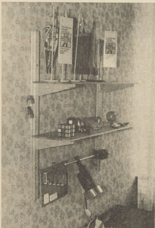
Slika 2. Nosilna letev je pritrjena z dvema lesnima vijakoma na vzdolžno letev
