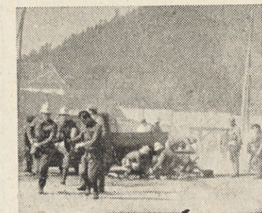
▲ Še malo in cev bo popravljena — potem še povečanje »Vodo!« in gašenje se bo pričelo
