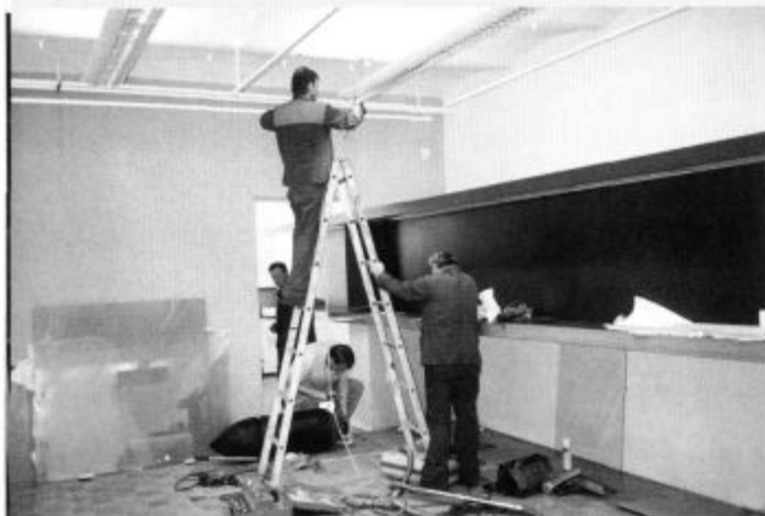
Pri postavljanju razstave sta pomagala tudi delavca podjetja Zidgrad iz Idrije.
