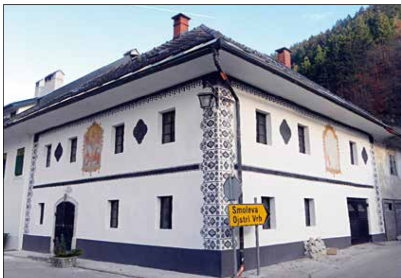
Kovačeva hiša po obnovi. Foto: Damjana Pediček Terseglav, 2011
