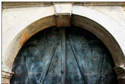
Detajl zgornjega dela portala in kovinskih vrat.
