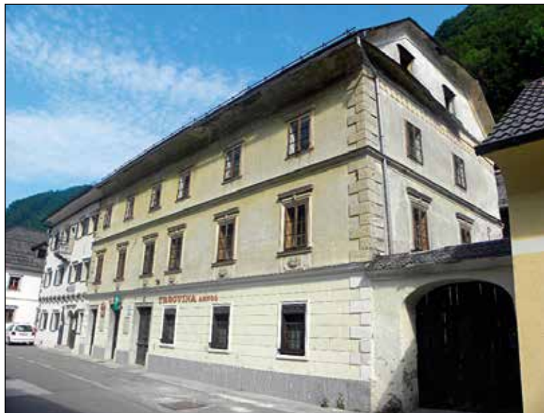
Boncljeva hiša pred obnovo. Foto: Damjana Pediček Terseglav, 2010
