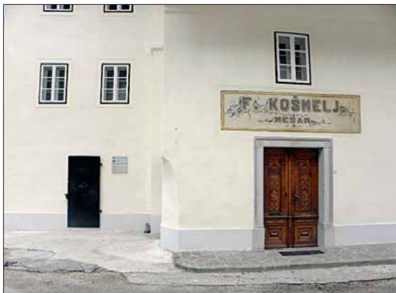
Odkrit in restavriran napis nad vrati. Foto: Damjana Pediček Terseglav, 2010
