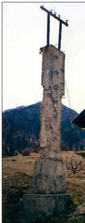
Betonski steber elektronapeljave okoli leta 1995 pred rušitvijo.
