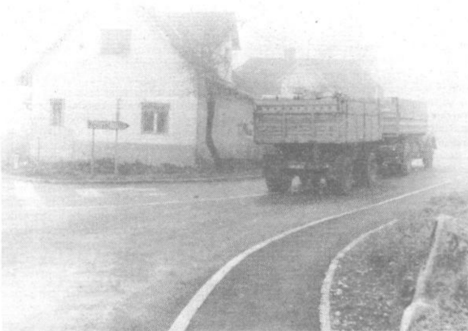
Prvi kilometri asfalta proti Mali Slevici
