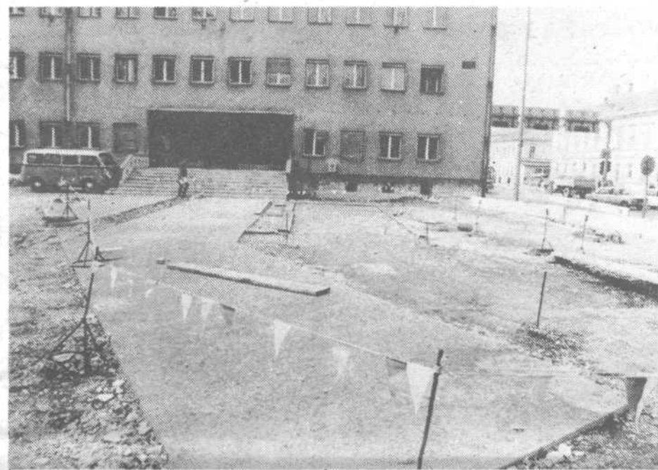
Pogled na urejanje ploščadi pred stavbo občinske skupščine
