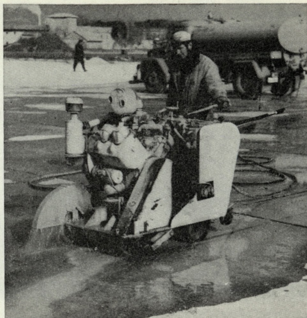
Sl. 3. Rezalec betona »Kristiansen« pri delu
