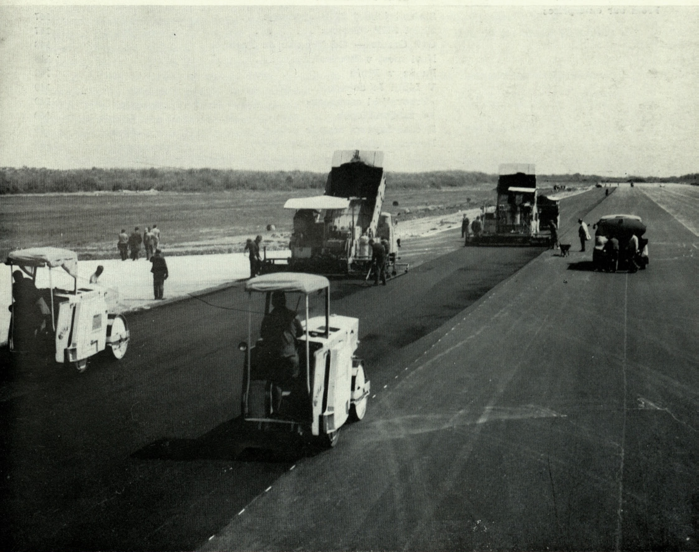
SGP SLOVENIJA CESTE: Obnova vzletne steze na letališču Pula (Foto: P. Strnad)
