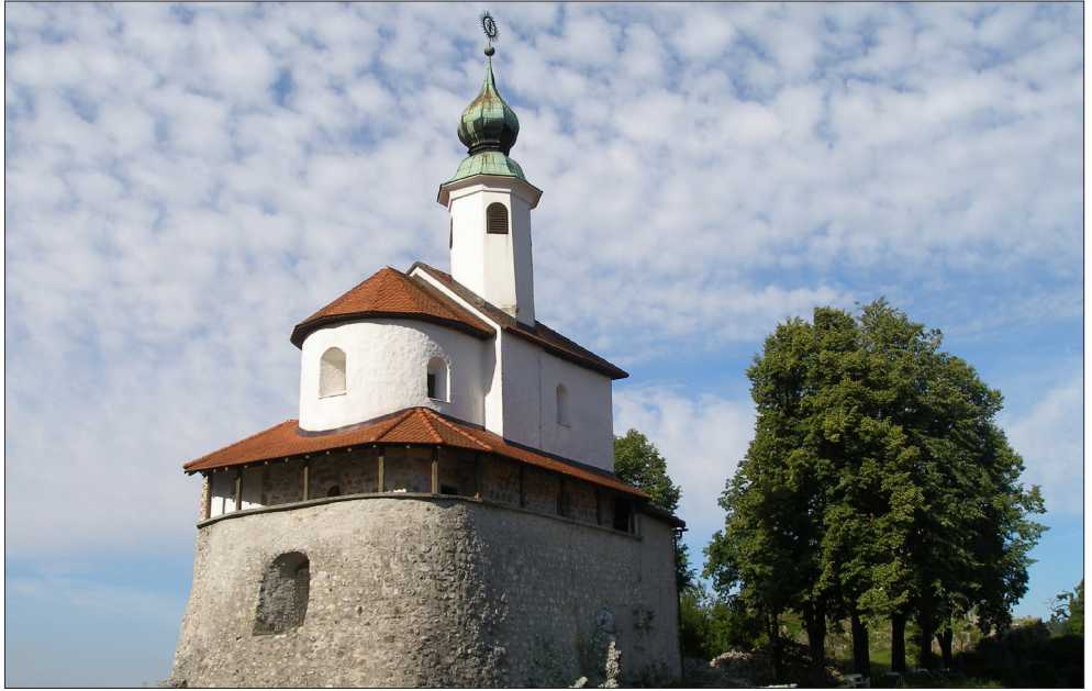
Slika 7: Kapela na Malem gradu je primer sakralne stavbne dediščine.
