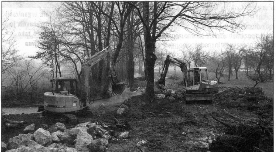
Delo za zagotavljanje poplavne varnosti v Šmartnem ob Dreti (foto: Marija Lebar)
