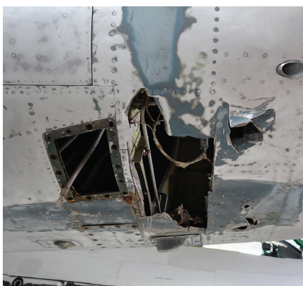
Poškodbe oplata na zadnjem delu trupa kažejo posledice prejšnjega nestrokovnega dviganja letala na območju letališča in letalske baze Brnik. Manjkajoče in uničene oplate je bilo treba nadomestiti z novimi. (Foto: arhiv Tomaža Permeta)
