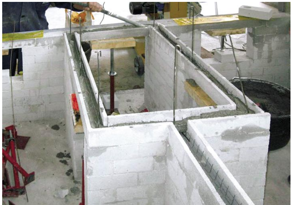
Slika 8 • Beli strop: betoniranje vodoravnih zidnih vezi in preklad
