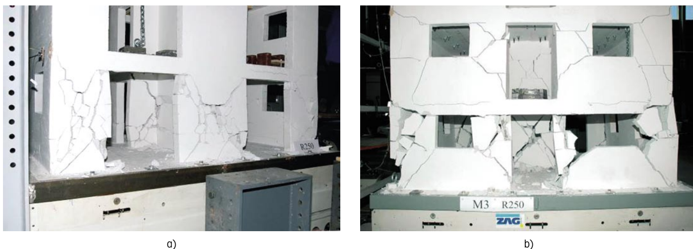
Slika 14 • Tipične poškodbe zidov modelov pri mejnem stanju porušitve a) model M2; b) model M3; parapeti niso poškodovani
