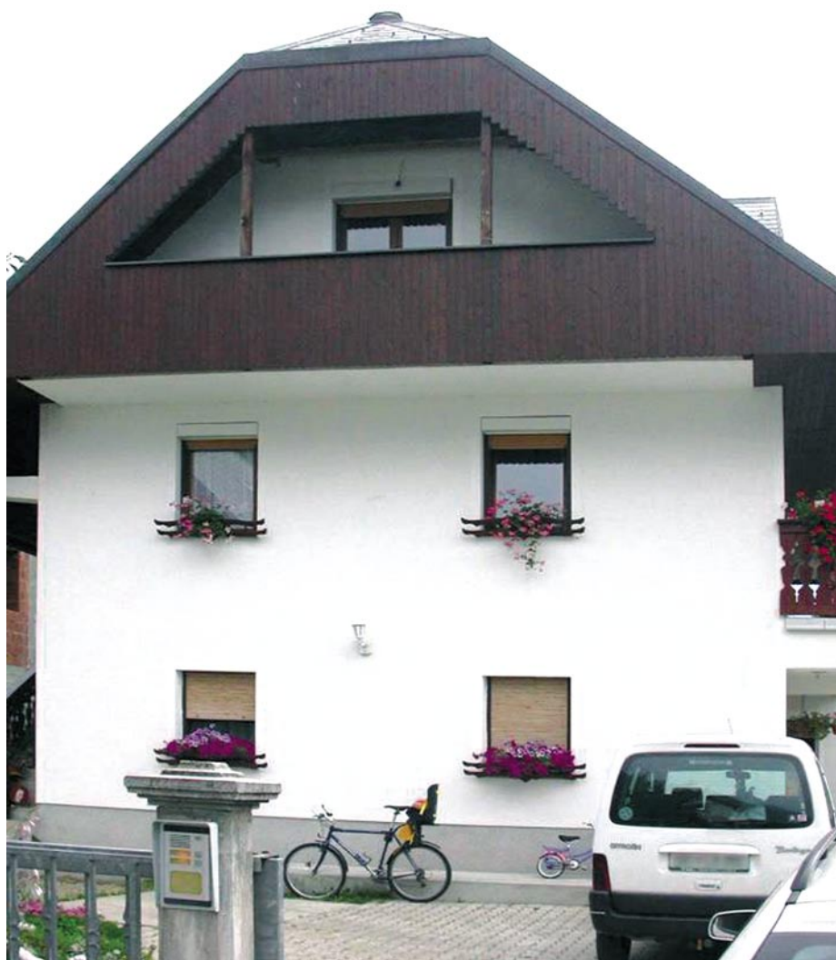
Slika 1 • Hiša v Bovcu, sezidana iz porobetona v sistemu Yfong, je potres leta 2004 prestala brez poškodb (foto: Uroš Klemen)
