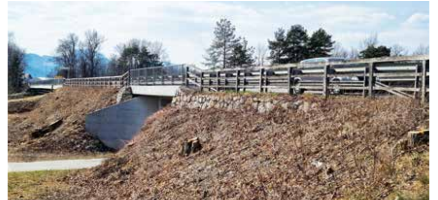
Čez most in nad podvozom bo urejena nova steza za kolesarje in pešce.
