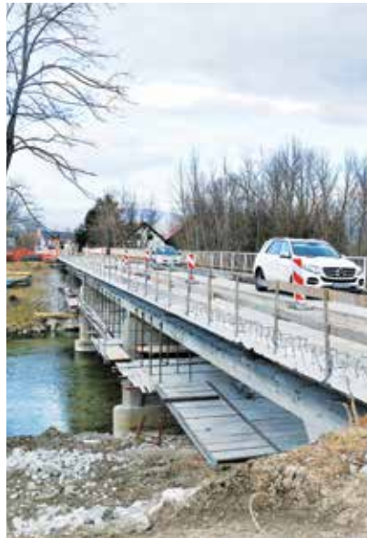
Dela na kasaškem mostu so se zaradi hladnega vremena podaljšala.
