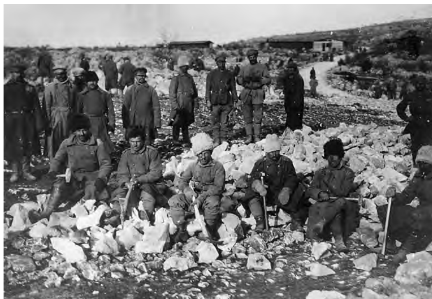
FOTO 27: GRADNJA VODOVODA NA KRASU. VIR: KOBARIŠKI MUZEJ.
