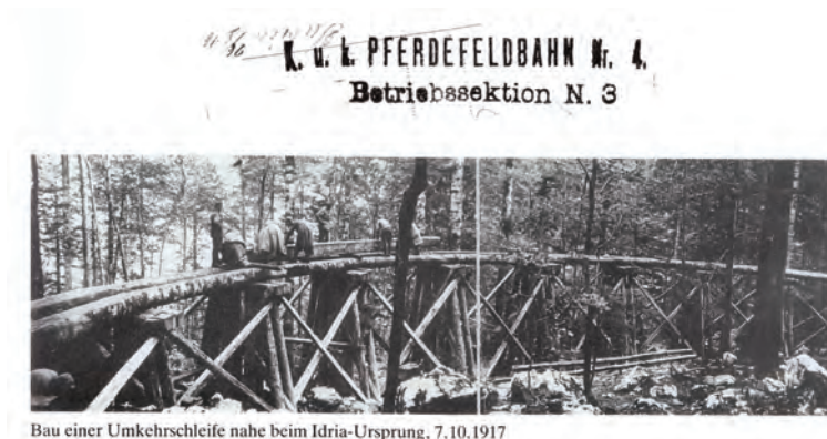
Bau einer Umkehrschleife nahe beim Idria-Ursprung, 7.10.1917
