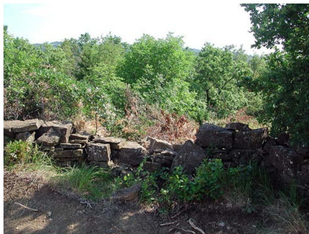
73 Na vrhu 1, ostanki zidu iz večjih kamnitih blokov, ki je ločeval parc. št. 705/1 in 706/2.
