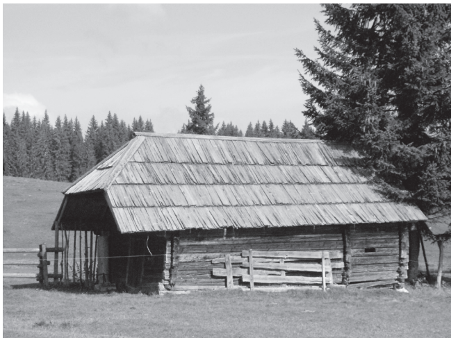
Knofelnov stan pred obnovo.
