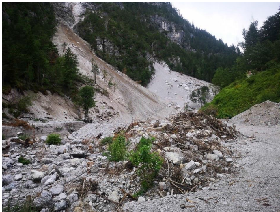
Slika 2: Skalni podor Belca – pogled gorvodno (povzeto po Matič, 2019).
