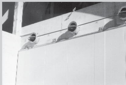
□ Slika 5. Zračniki, pritrjeni na steno sušilnice
