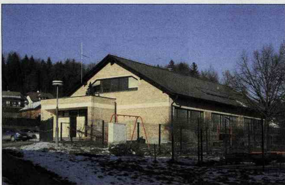
Pri podružnični osnovni šoli v Šentvidu bodo letos začeli graditi telovadnico.
