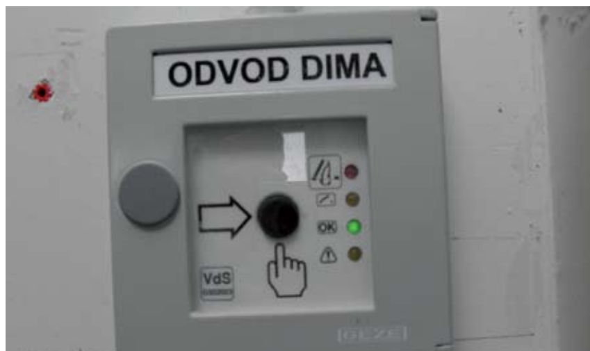
Slika 7: Ročno proženje sistema za odvod dima in toplote
