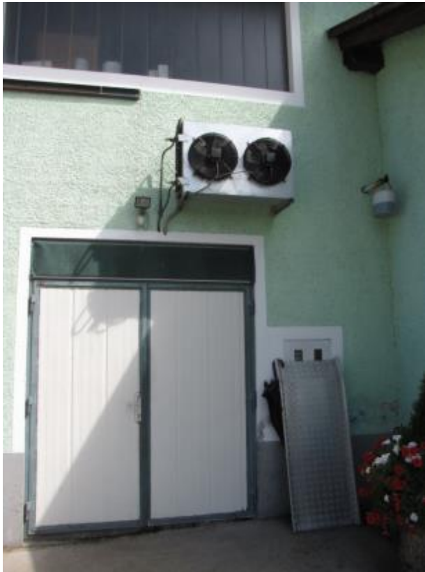
Slika 20: Za manjšo porabo energije se priporoča, da je hladilni agregat (kompresor) nameščen ločeno od hladilnega bazena z mlekom.
