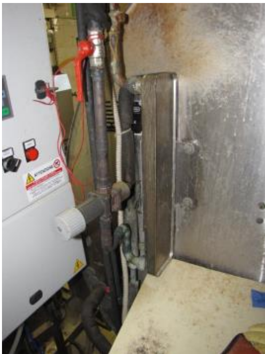
Slika 21: Dober primer izkoriščana odpadne toplote, ki nastane pri hlajenju mleka. Na eni kmetiji dnevno namolzejo 1250 litrov mleka, ki ga ohladijo na 3,5 °C. Z odpadno toploto pa ogrevajo preko toplotnega izmenjevalca vodo na 55 °C, ki gre nato v 500 litrski hranilnik toplote. Vročo vodo uporabljajo za čiščenje molzišča in mlekarne. Potencial tako pridobljene
