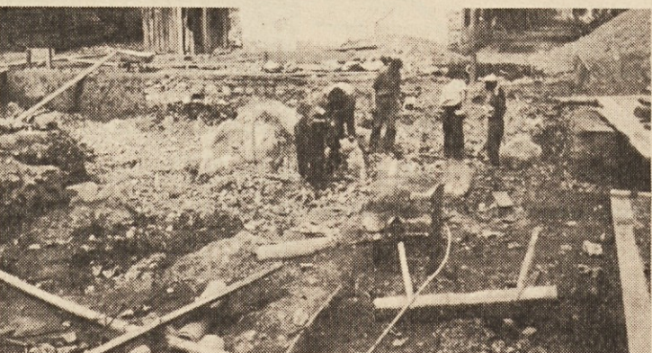
Junij 1963 — priprava gradnje restavracije v Ribnici. Stoletne lipe, ki so jo sprva hoteli vgraditi v lokal, ni več. Kopanje temeljev še precej ročno.
