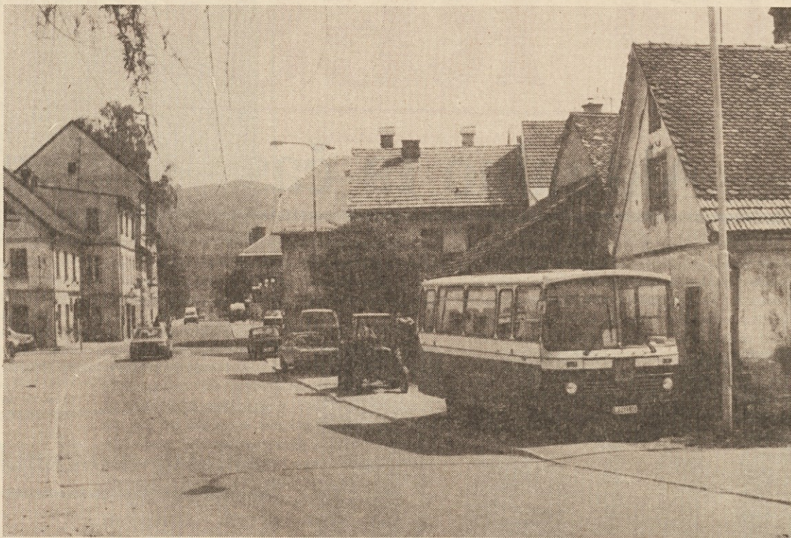
Tudi Urbanova ulica bo v okviru prenove prvega dela ribniškega središča povsem na novo pozidana.
