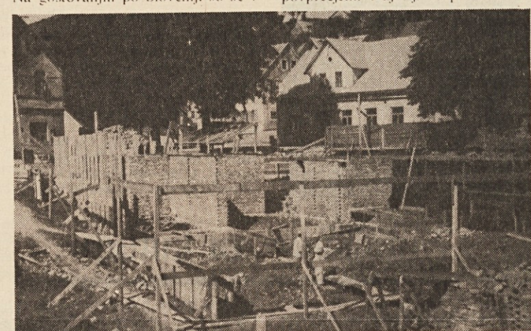
Poleti 1965 — gradnja trgovske hiše v Loškem potoku lepo napreduje
