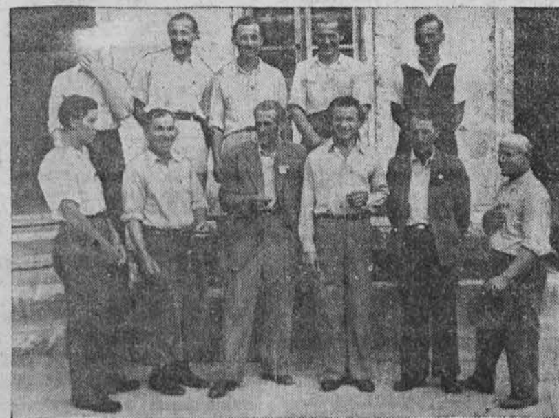
Udarniki gradilišča hidrocentrale v Mostah pri Zirovnici
