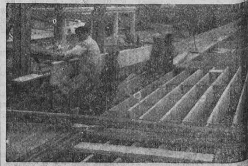
Litostroj: Delavci vzdavajo težke "čokoladne pločče" ali takimenovane Ferjanove nosilce
