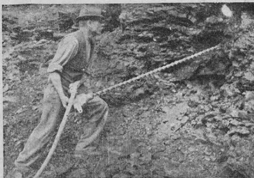
S kompresorjem v premogovne plasti, ki jih bo kasneje zrušilo razstreljivo—Trboveljski rudnik "Drobna"
