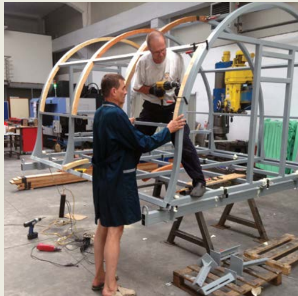
Montaža lesene konstrukcije Arhiv AO PD Jesenice
