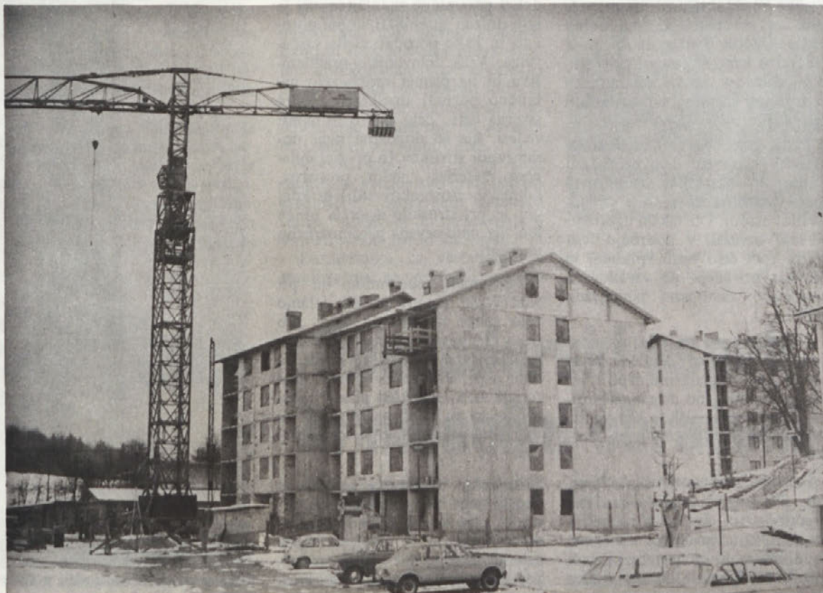
Pogled na del nove stanovanjske soseske, ki jo na Drski v Novem mestu gradi TOZD Gradbeni sektor Novo mesto. Na sliki sta vidni dve vrsti izmed 4 različnih inahic blokov, ki so tam v gradnji
