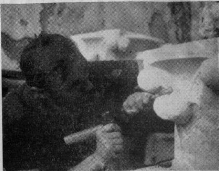
Ivan Pavline pri obnovitvenem delu
