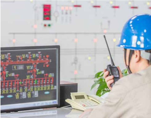
Slika 2: Spremljanje stanja zapirnih ventilov v nadzorni sobi
