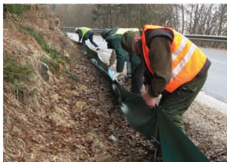
Postavljanje ograje za dvoživke
