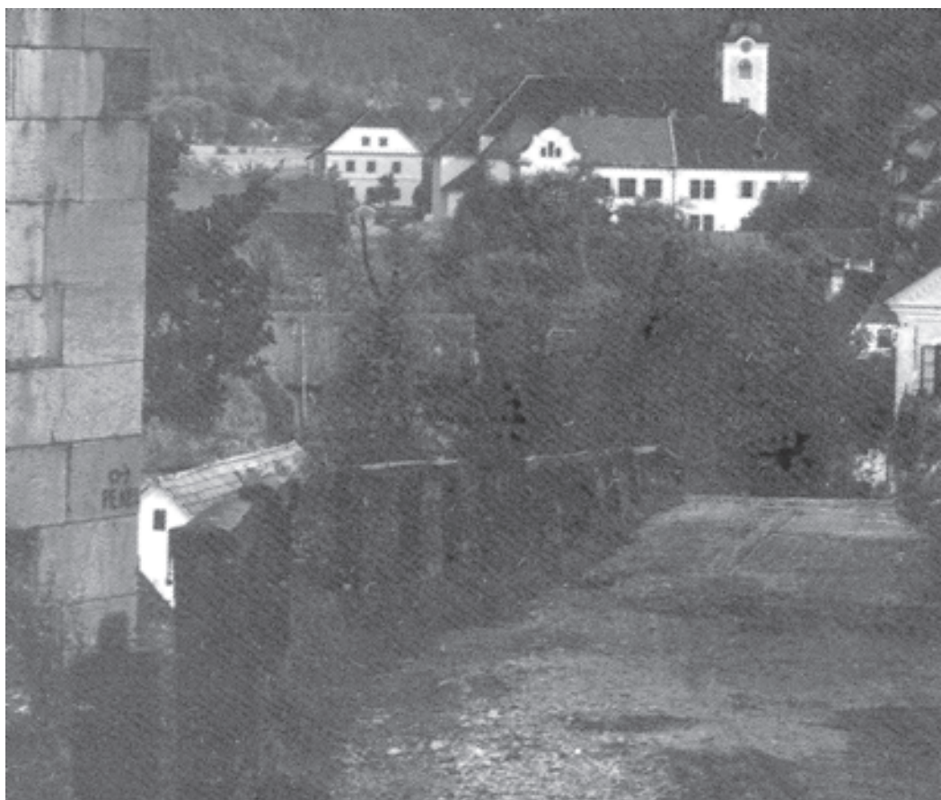
Na steni stebra viadukta je markacija za Pekel.
