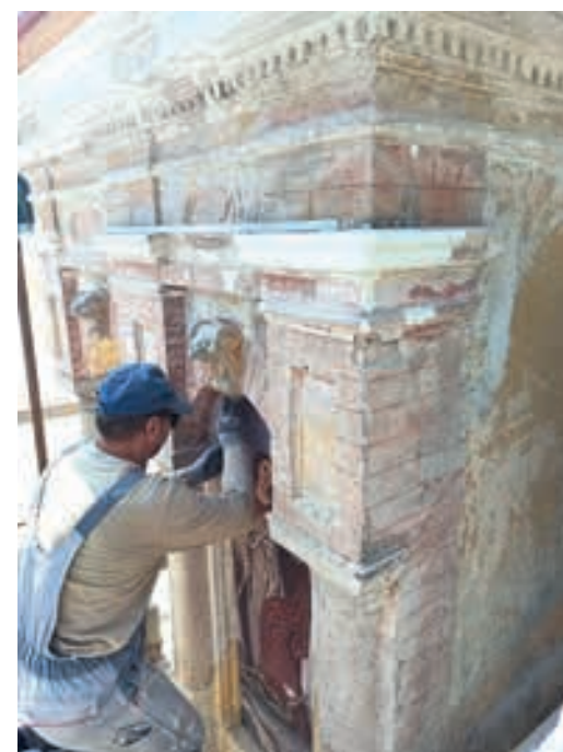
Mojster med obnovo kapelice.
