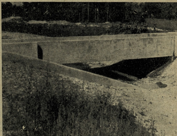
Akvadukt pri Polzeli — Le drainage — l'aqueduc près de Polzela — The drainage — aqueduct near Polzela — Meliorationsarbeiten — der Acquadukt bei Polzela
