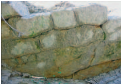
Slika 234: Pretrta plast peščenjaka lahko »štrli« po več decimetrov iz stene; tudi na erozijskem žarišču, kjer so potekale meritve.
