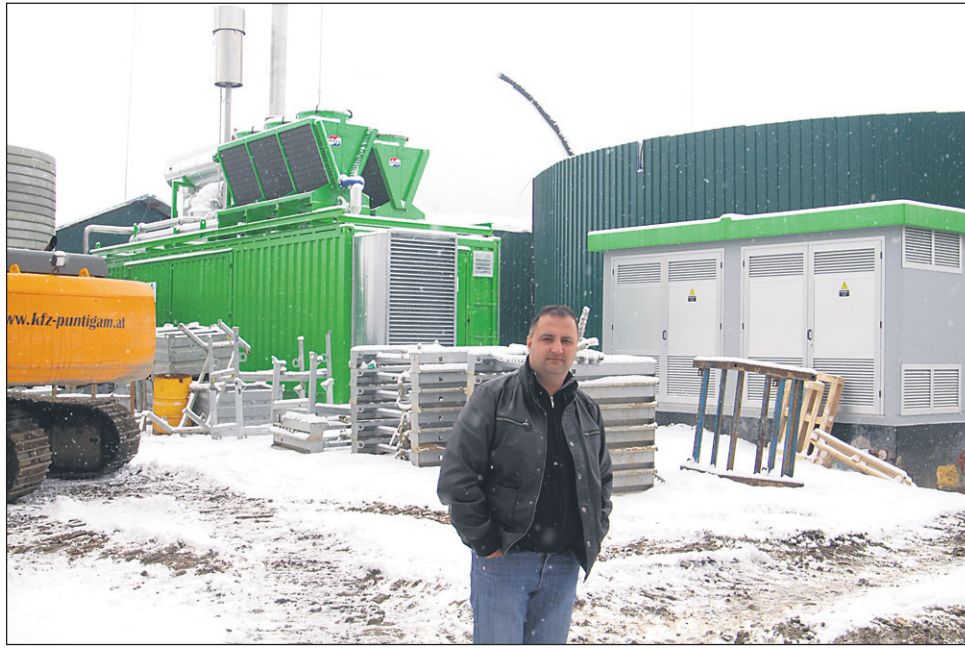
Investitor Miran Vargazon pred nedavno montiranim bioplinskim motorjem z generatorjem in transformatorjem, ki pomenijo srce nove bioplinske elektrarne v Sobetincih. Kljub novozapadlemu snegu potekajo dela pri gradnji posameznih objektov elektrarne nemoteno naprej.
