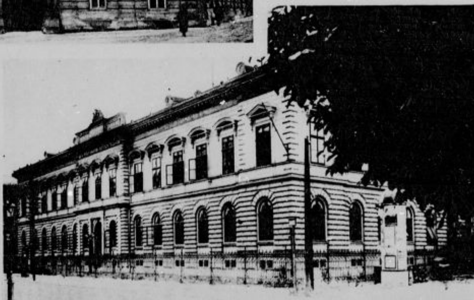
Poslopje Kranjske hranilnice, ki bo dvignjeno in podaljšano.
