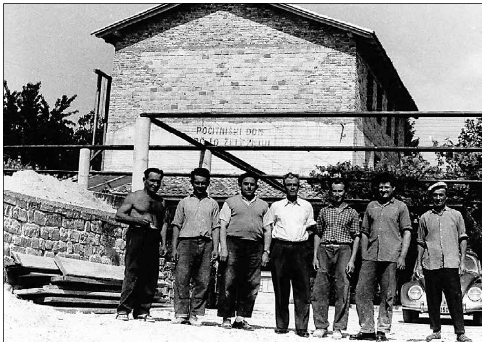
Leto 1961. Ob zaključku nadzidave počitniškega doma. Delavci pri gradnji v sredini, tretji z leve Alojz Megušar – vodja gradbenih del; četrty z leve Anton Dagarin – zidarski mojster iz vasi Meja pri Kranju. Foto: Blaž Dolenc
