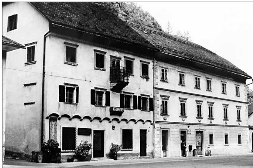
Plavčeva hiša (Na plavžu 58) z Bonceljnovо (Na plavžu 57) pred obnovо.
