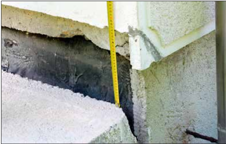
Pogled na odmik pločnika od stanovanjske hiše, 2. 9. 2010.
