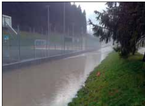
Narasla voda je zaradi pravilne gradnje prizanesla športnim objektom.
