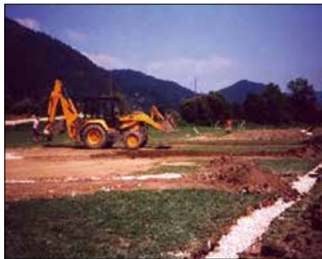
Sanacija nogometnega igrišča.
