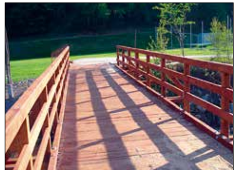
Za prenovo močno načetega mostu je v celoti poskrbela Občina Železniki.
