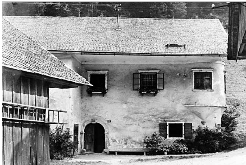
Plnada pred obnovo.
