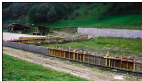
Okrog teniških igrišč smo zabetonirali metrski oporni zid zaradi zavarovanja proti izlitju Sore.
