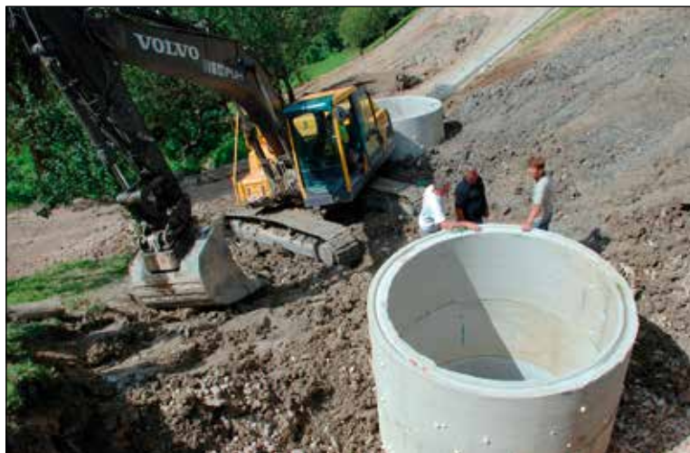
Izvedba drenažnega vodnjaka pod zgornjo pilotno steno za zbiranje globinskih voda (d = 2,5 m), 2. 9. 2010.
