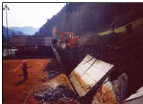
Sanacija opornega zidu na igriščih za tenis.
