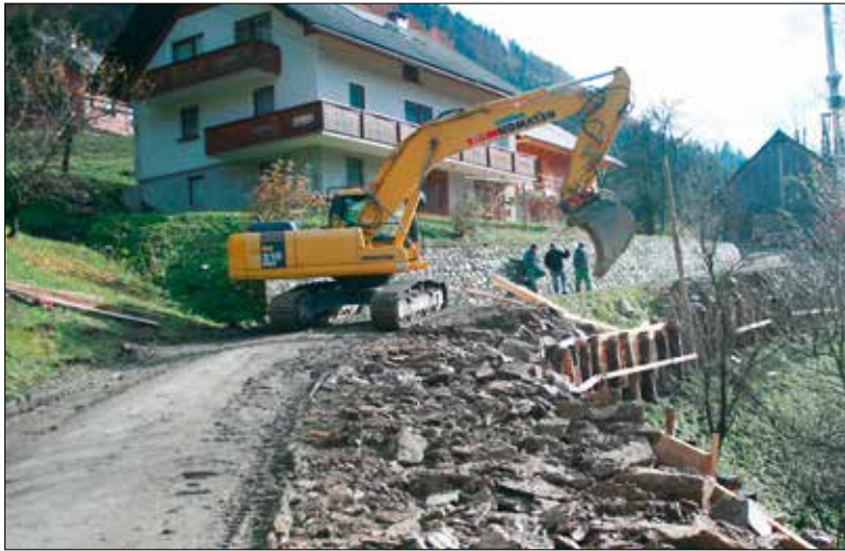
Priprave za vrtanje zgornje pilotne stene, 5. 11. 2009.
