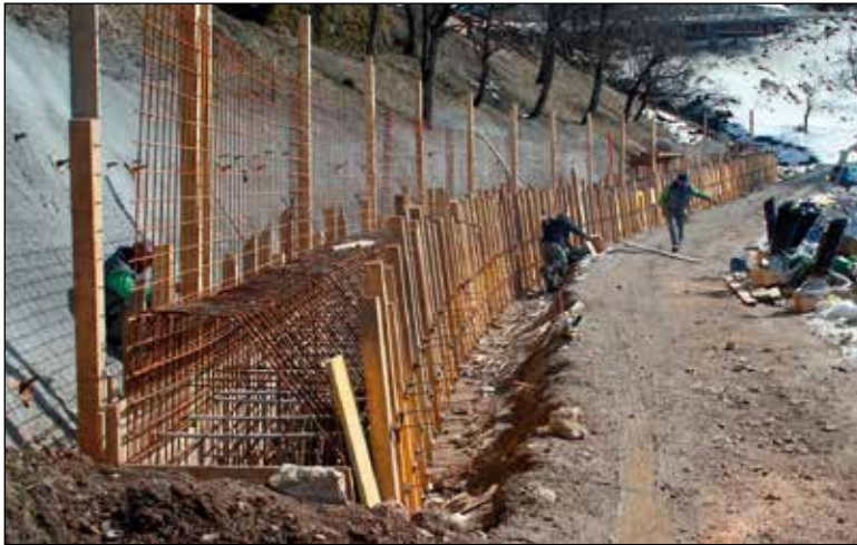
Izdelava AB-grede – spodnja pilotna stena, 16. 3. 2010.
