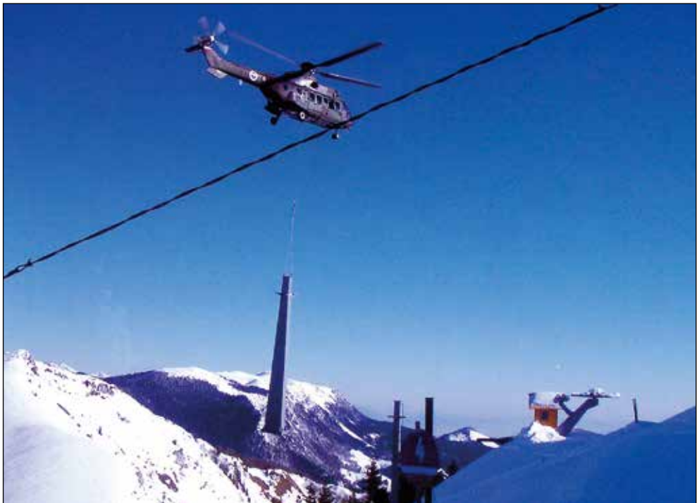
Postavljanje stebrov dvosedežnice.
