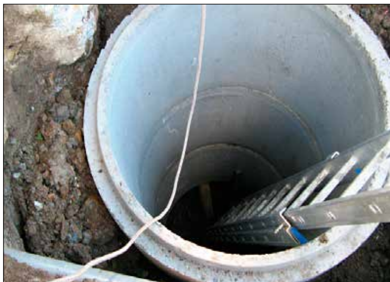
Izkop stabilitetnega vodnjaka pri hiši Smoleva 1 ( d = 1,20 m).
