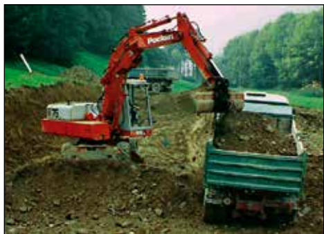
Izkop zemlje za teniško igrišče.
