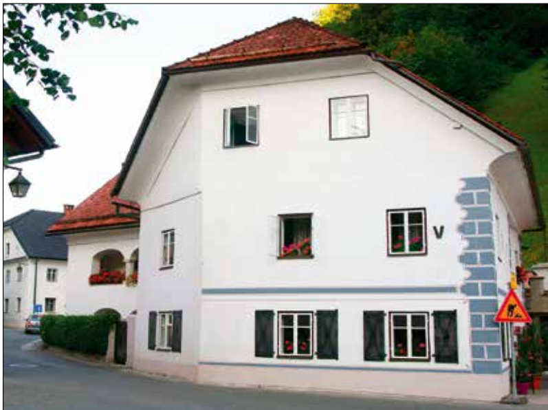
Na plavžu 34 po obnovi.
