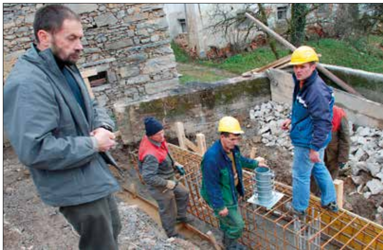
Izdelava AB-grede, ki povezuje pilote in sidra, 10. 12. 2009.
