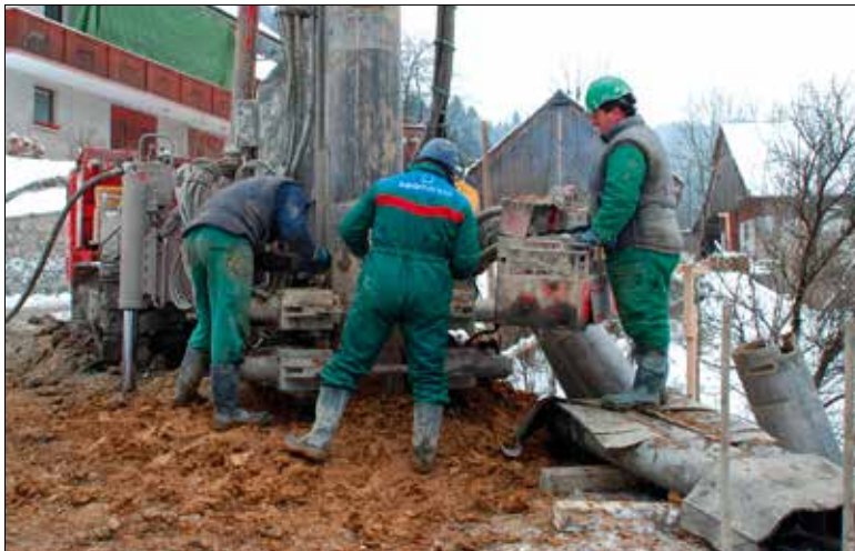
Vrtanje zgornje pilotne stene (pilot d = 0,4 m), 10. 12. 2009.
