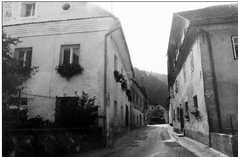
Na plavžu 37 in 38 pred obnovo.
