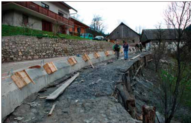
Zaključevanje pilotov in mikro pilotov, kjer je vgrajen inklinometer, 15. 4. 2010.
