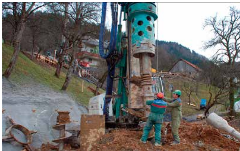
Vrtanje spodnje pilotne stene (pilot d = 0,80 m), 10. 12. 2009.
