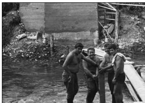
Izgradnja prvega mostu na Rovnu.
