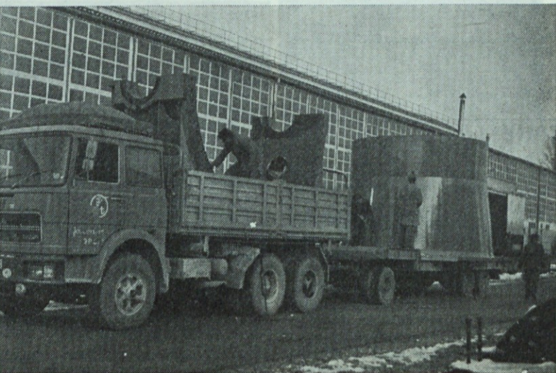
Del vodilnika in gonilnika za HE Zakučac
