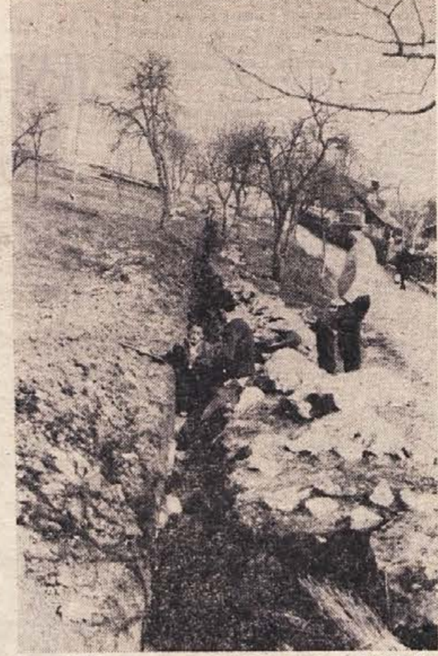
H gradbišče novega prosvetnega doma v Veliki Dolini (pri Brežcah) je treba potegniti tudi vodovod. Stanovaleci obrobnihi hiš, ki bodo na ta način prišli do vode, pridno pomagajo pri koprojanju jarka. Tu se pozna vpliv prizadevanja dela krajevne organizacije Socialistične zveze, ki ima med ljudmi velik ugled.
