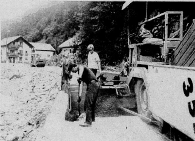
Asfaltiranje ceste v Podvolovljeku
