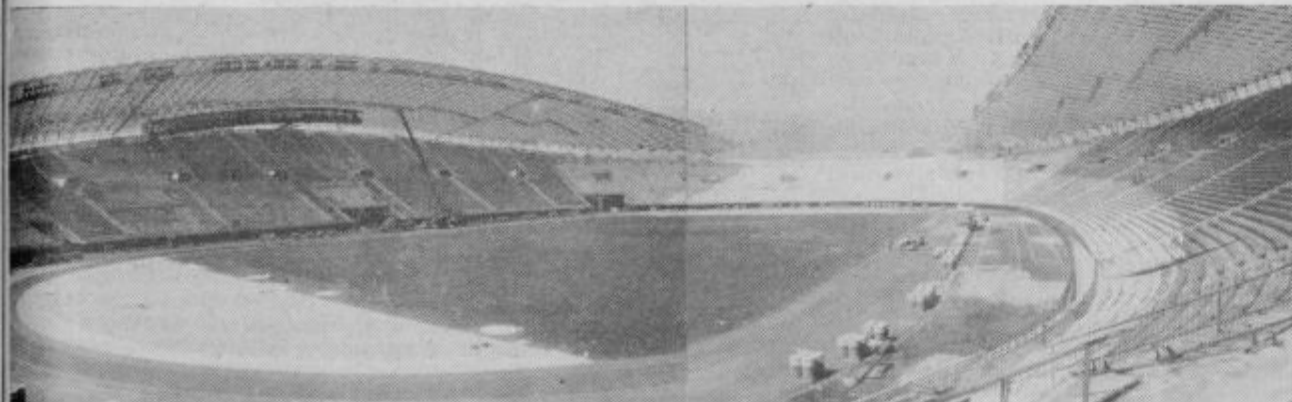
Nas stalni sodelavec Lojze Ojsteršek si je med letošnjim dopustom v Dalmaciji ogledal tudi gradnjo novega stadiona v Poljuju v Splitu, ki bo sprejel preko 50 tisoč ljudi. Nastal je takle posnetek tega mogočnega objekta, ki po svoji zunanosti sodi med najlepše tovrstne objekte pri nas in v svetu. Seveda je danes njegova zunanost že mnogo drugačnejša, saj je do iger in otvoritve, ki bo na tem stadionu, ostalo samo še devetnajst dni!
