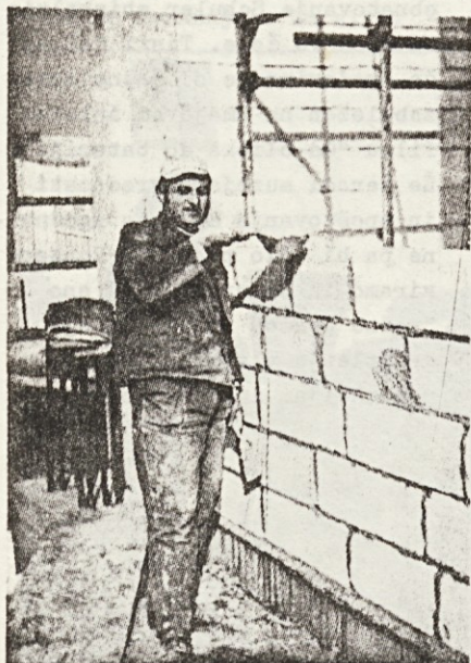
Kamen na kamen, blok na blok - zid. Zidanje obodne stene.
