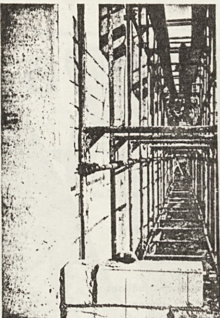
Sence in sonce pod odrom postavljenim za zidanje obodne stene.
