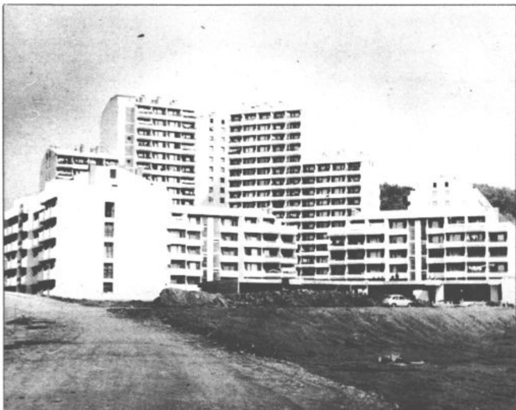
Stanovanjski bloki v novi soseski Šalek — Gorica, ki jih gradi GIP Vegrad Velenje
