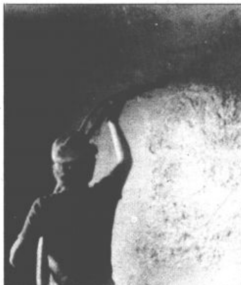
Strojno ometavanje z malto EFE
