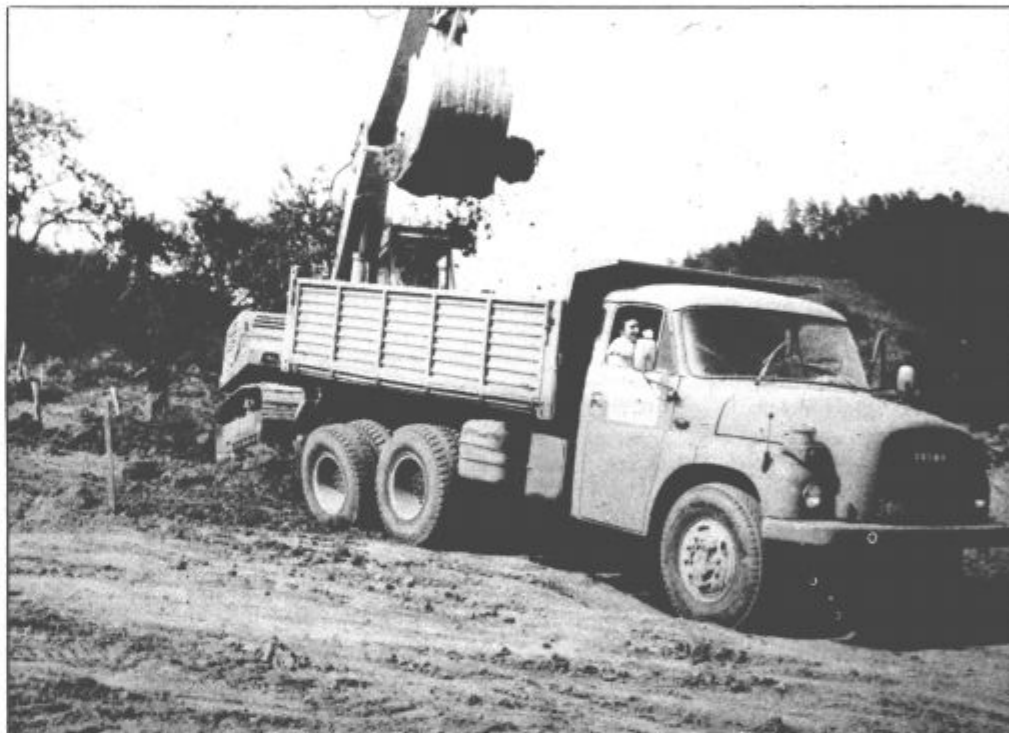
Z gradbišča Šaleške magistrale: izvajalca del sta NIVO Celje in KOC Velenje.
