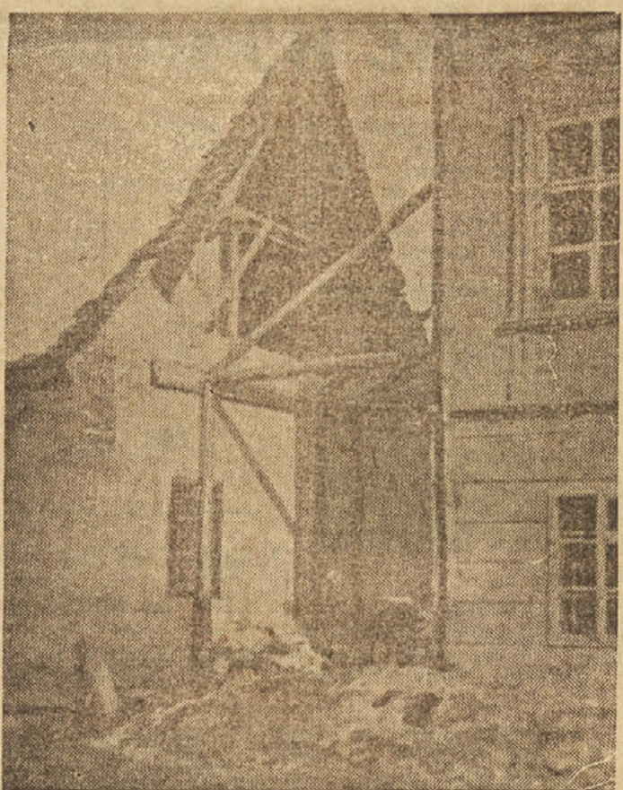
Poslopje stare pošte po potresu
