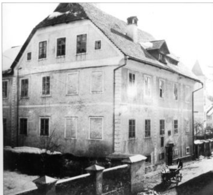
Švica pred obnovo ...
