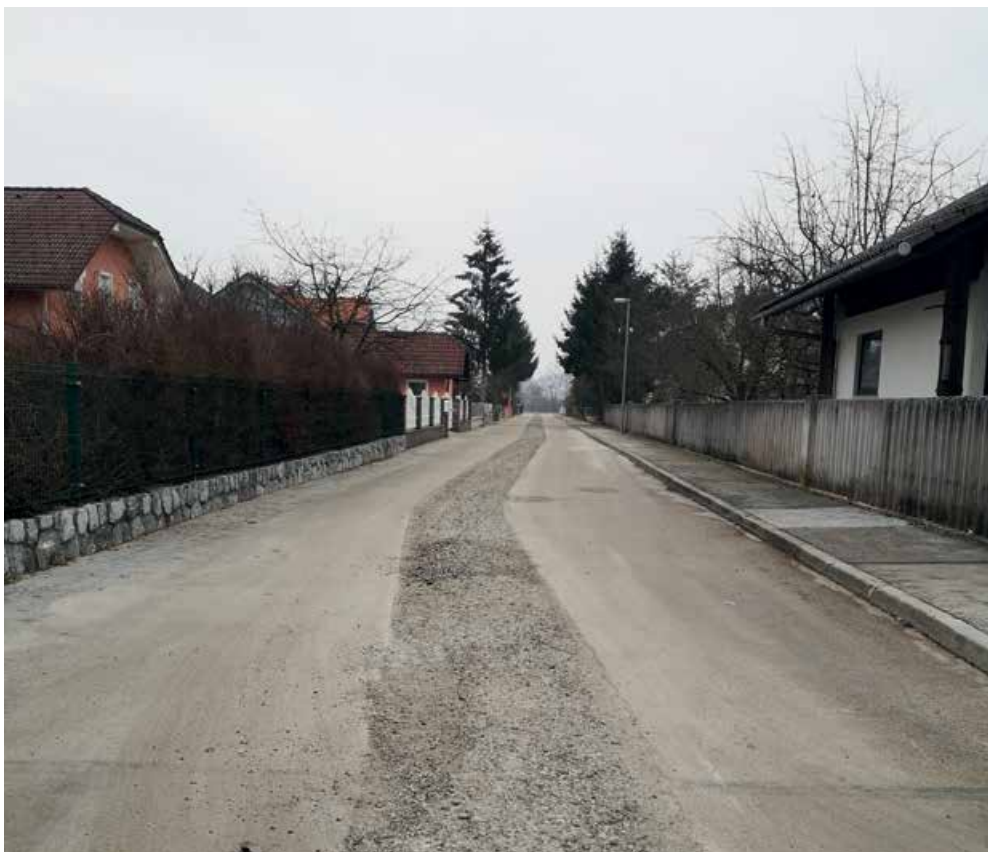
Odstranitev asfalta na trasi obnove vodovoda
