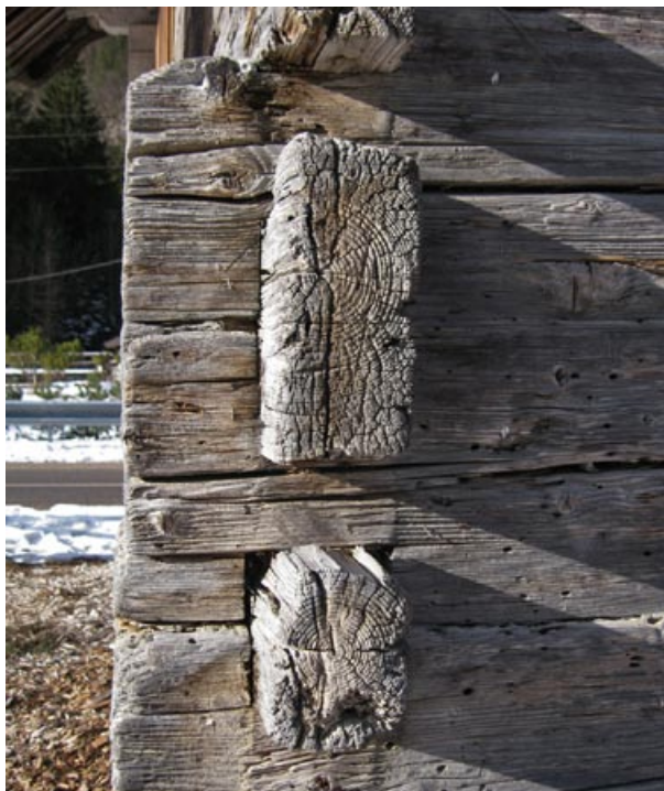
■ Slika 4: Logarjeva kašča (Logarski dolina 7) ima na vogalih štiristrano obdelana bruna povezana z utori »na križ« (foto: Vito Hazler)
