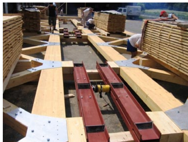
■ Slika 8. Obremenilna preizkušnja nosilcev Figure 8. Load-bearing testing of girders
