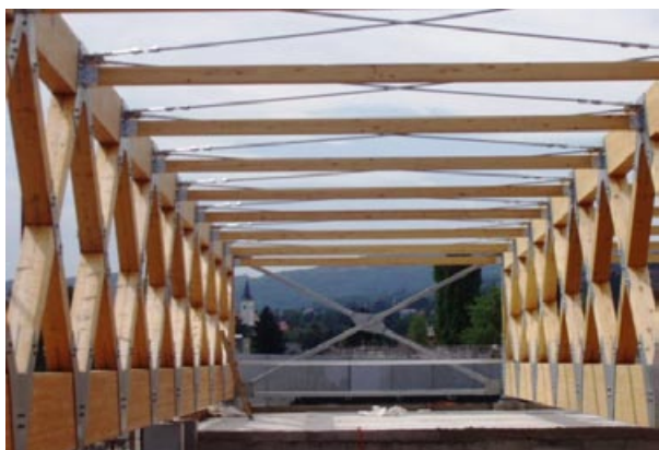
■ Slika 10. Pogled na montirane nosilce Figure 10. Girders after placing
