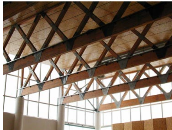
■ Slika 14. Pogled na nosilce po zaključku montaže Figure 14. Girders as placed over the sport hall
