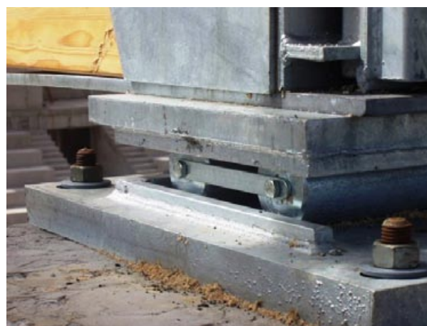
■ Slika 13. Klasična premična podpora Figure 13. Classic movable girder support
