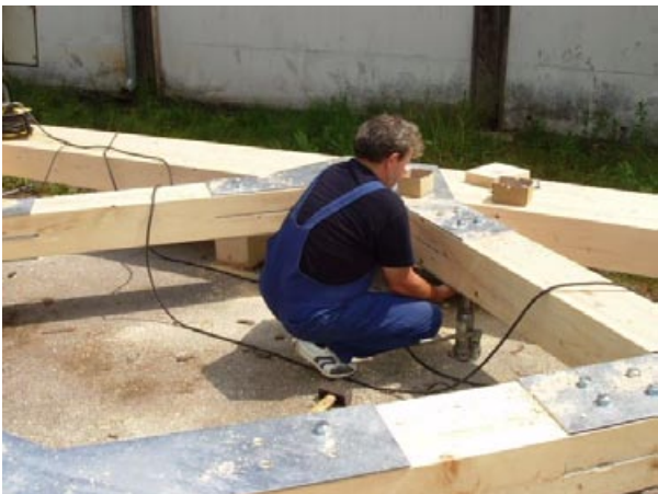
■ Slika 7. Izdelava lesenih paličnih nosilcev Figure 7. Production of wooden truss girders
