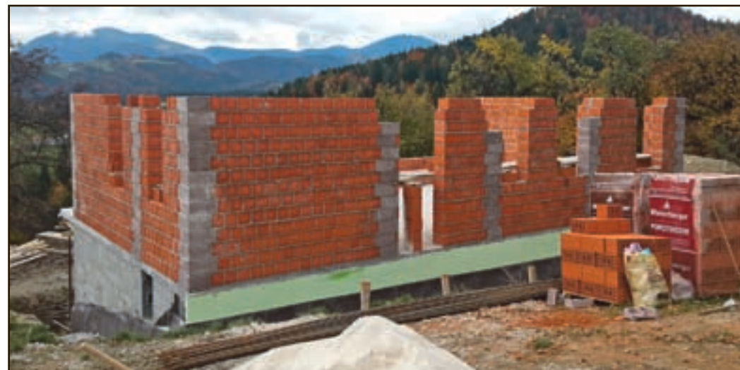
Gradnja napreduje. (foto: arhiv Občine Šoštanj)
