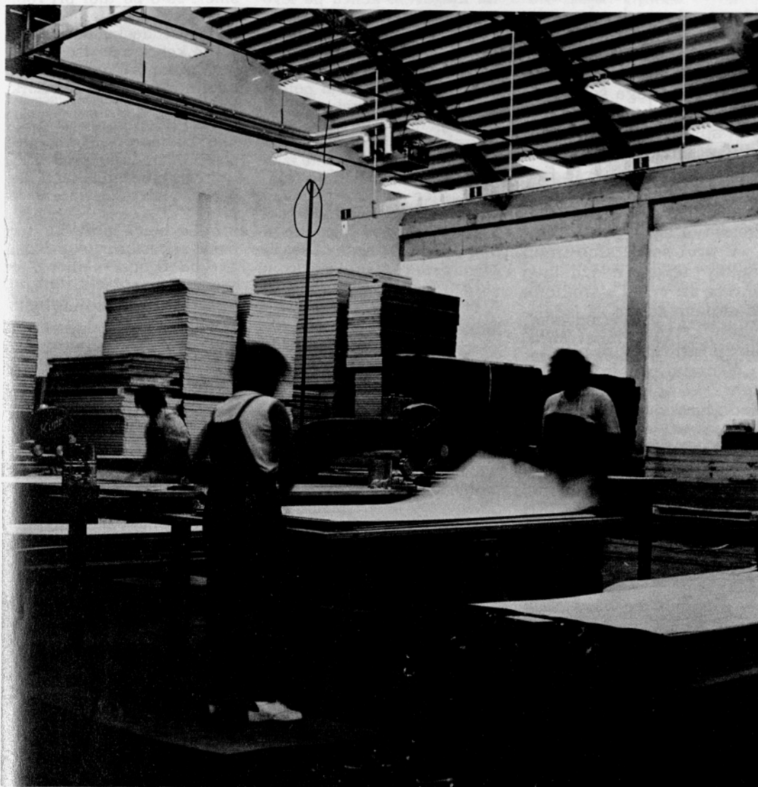
Restavljanje in spajanje furnirja v proizvodnji vrat v TO Rečica
