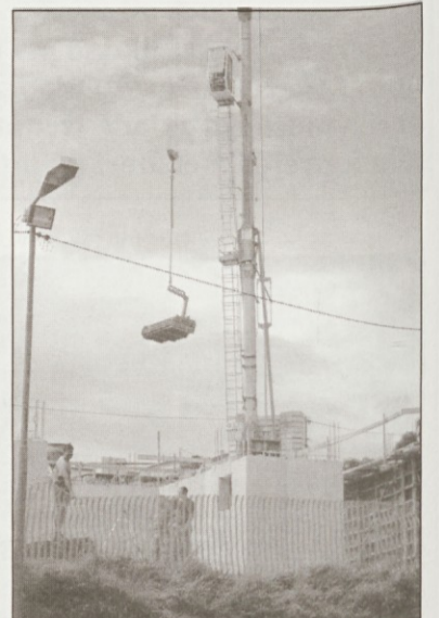
Izvajalci so slab mesec od položitve temeljnega kamna že zgradili prvo etažo prvega stolpiča v katerem bo 22 stanovanj. FOTO: Primorski utrip.
